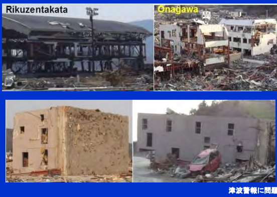
コンクリート構造物も被害を受けた
