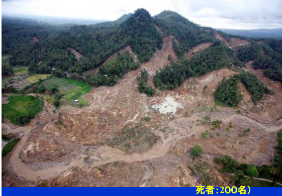
Padang Alai 地域 - 斜面崩壊・地すべりダムとその崩壊
