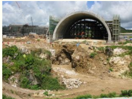
建設中の空洞対策工
