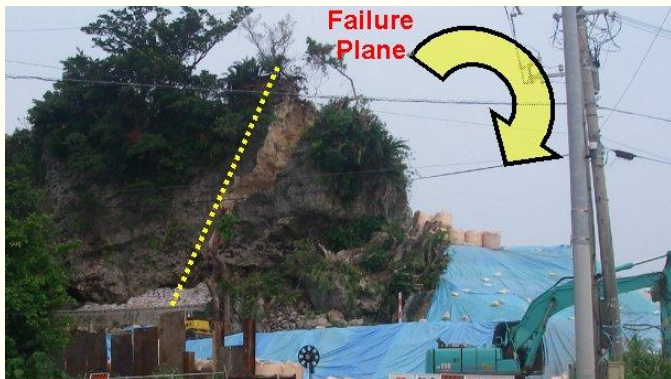
石灰岩層オーバーハングの崩壊(南城市)
