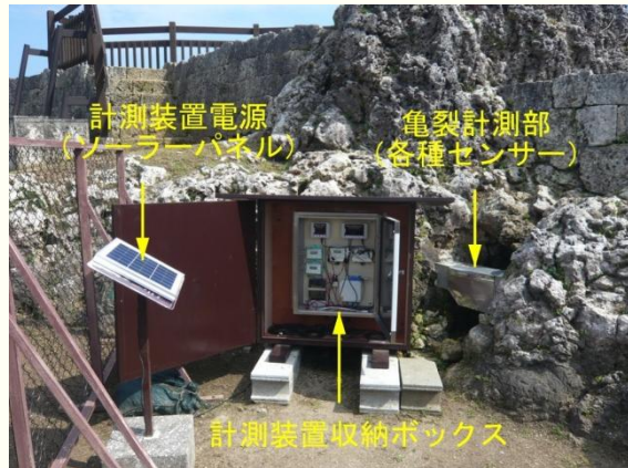
多重パラメータ計測システム設置状況(中城城社)
