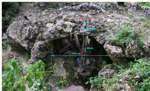
石積みアーチ構造(伊江殿内)
