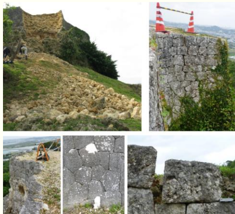
地震発生による勝連城社の被害
