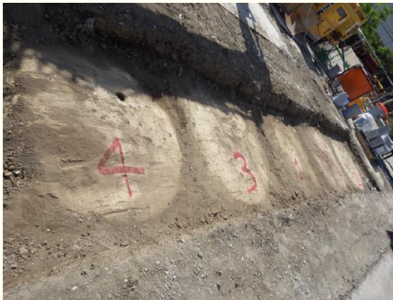
大口径機械攪拌深層混合処理による改良体の全景
