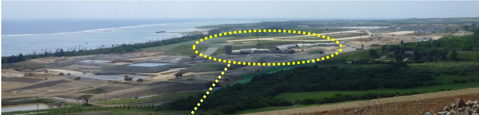
建設中の新石垣空港
